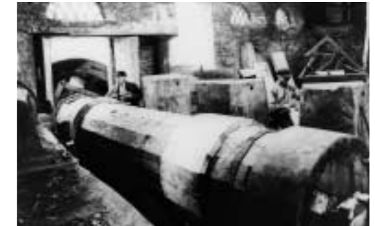
Deilbachhammer, Einbau einer neuen Hammerwelle, 7.10.1936 Stadtbildstelle
