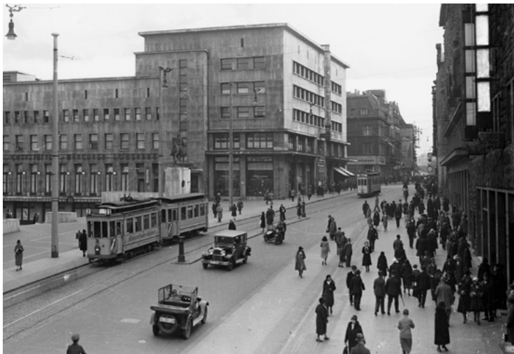
Blick auf die Lichtburg in Essen, um 1930
